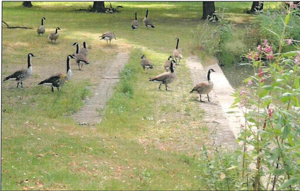
Abb. 13: Rasengittersteine an der Kanueinstiegsstelle
